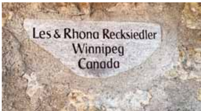
Spendensteine helfen die Stadtmauer zu erhalten.
