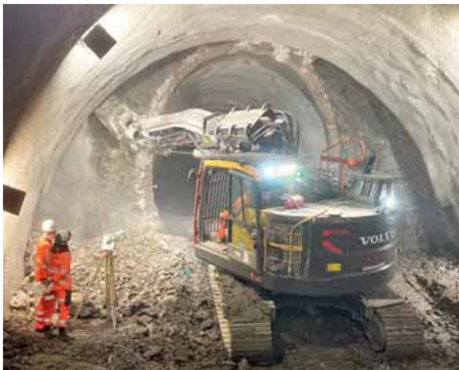
Die Tunnelmaschinen aus Hausen am Bach sind weltweit im Einsatz.
