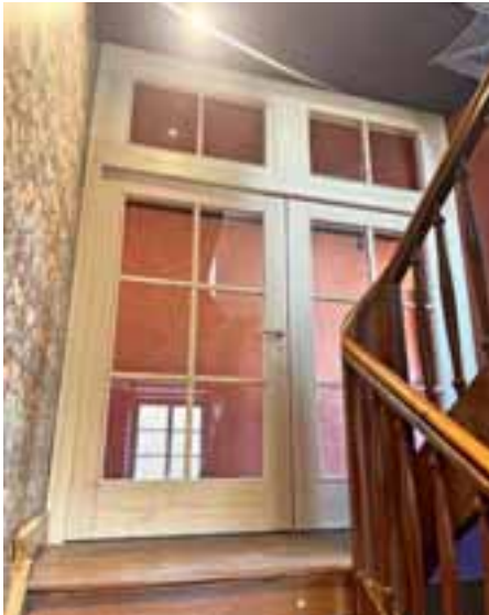
In der Altbausanierung, hier ein passgenauer Windfang, ist traditionelle Handwerkskunst gefragt. Foto: Privat
