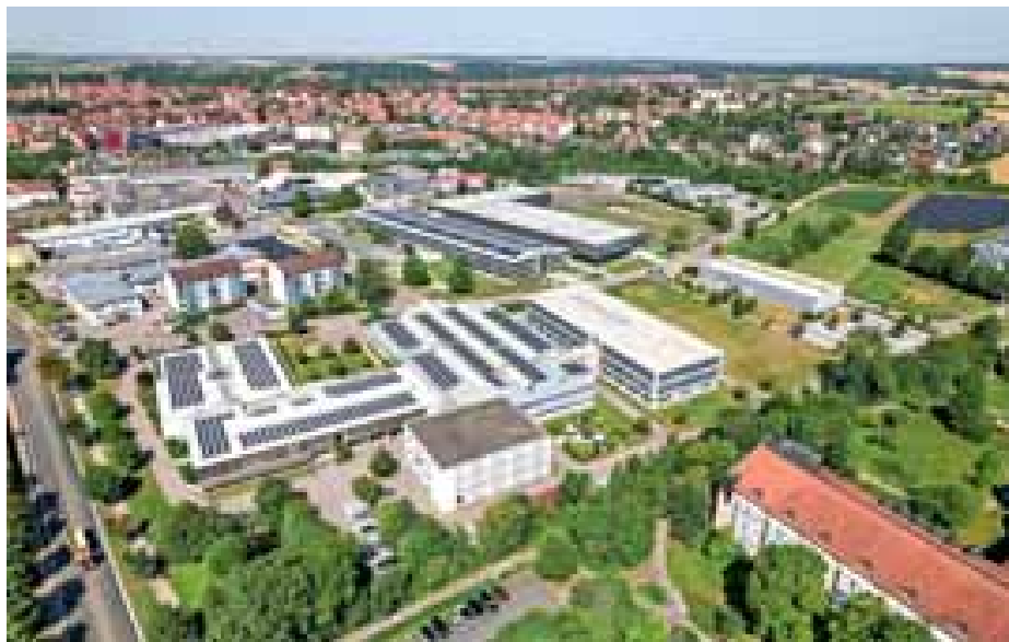
Das Unternehmen Neuberger aus der Luft gesehen. Im Monat werden rund 250 Schaltanlagen produziert. Wie das vor sich geht, können Interessierte am Tag der offenen Tür entdecken. Foto: Privat
